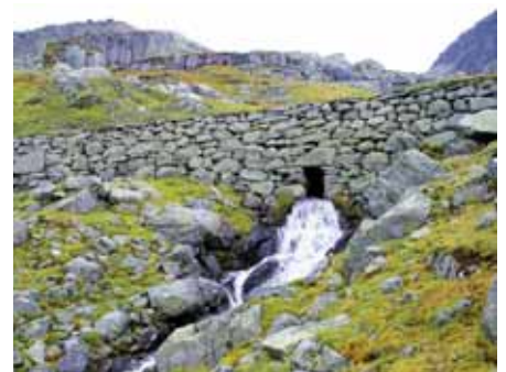
Tørrmur med stikkrenne, eksempel på gammel vegbygging.
