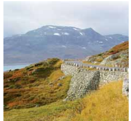
Parti fra veien utenom/over Vågslitunnelen.
