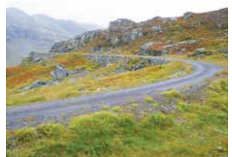
Fin, gammel vei utenom tunnelen ved Svandalsflona.
